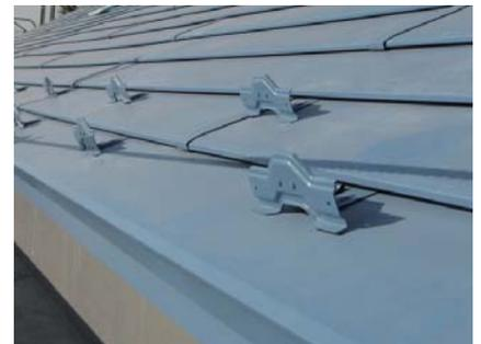
写真8 雪止め金具の例
