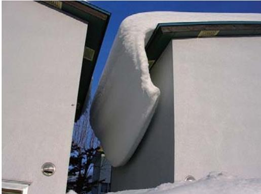
写真1 積雪による巻垂れの例
