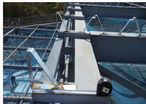
写真3 端部用タイトフレームの例
