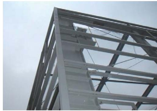
写真4 鋼板製外壁縦張りの出隅部
