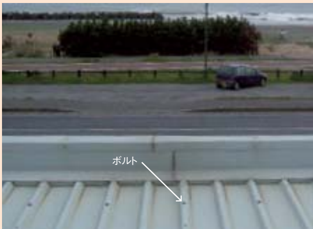
ステンレス(SUS430)製ボルトによる フッ素塗装55%Al-Znめっき鋼板
