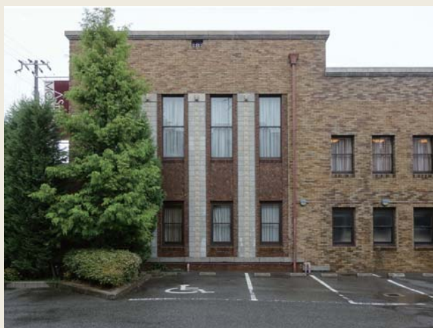
図1 芦屋モノリス(旧通信省芦屋別館、1929年竣工) 2005年2月に婚礼施設として再生された。優れた改修に与えられるBELCA賞(ロングライフビル推進協会)を受賞した。
