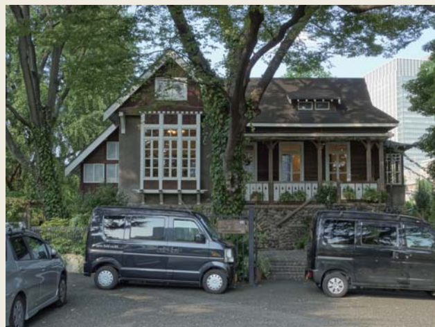
図2 フェリーチェガーデン日比谷(旧都公園資料館、1910年竣工) 2006年10月に婚礼施設として再生された。ブライダル業界の大手ワタベウエディングによる再生事例。
