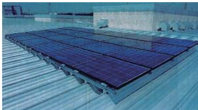
写真4 折板上での太陽光発電
