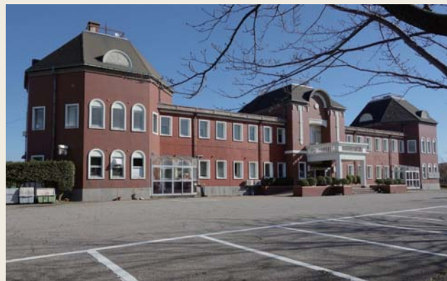
図2 サイクリングターミナル（小矢部市,1982年） 小矢部市の「メルヘン建築」シリーズの一つ。東京駅丸の内駅舎をモデルに作られた。市の説明によれば、実物の5分の1だという。
