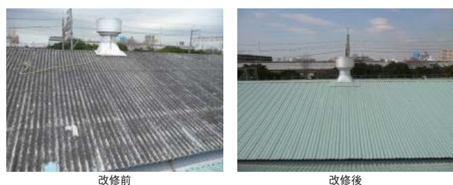
写真1 スレート屋根の改修
