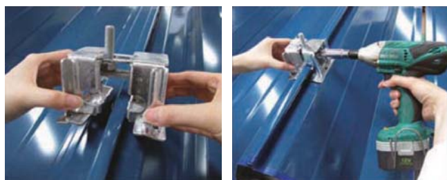
写真5 折板へのPVパネル固定用金具 7)
