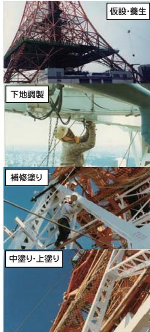
写真5 塗替塗装作業の状況
