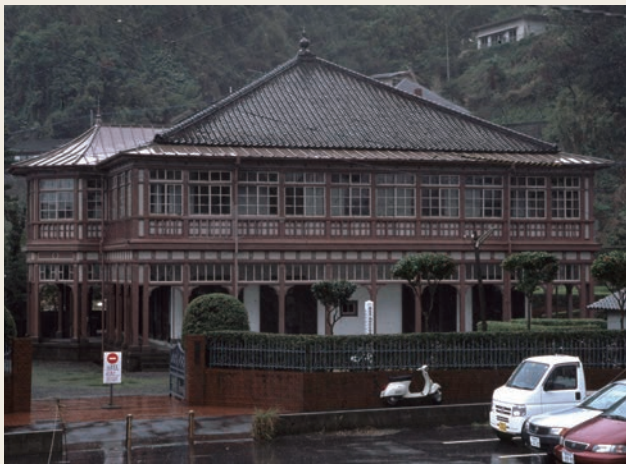
図3 異人館(旧鹿児島紡績所技師館、鹿児島) ウォートルスは一部屋を与えられ、製図室として使った。
