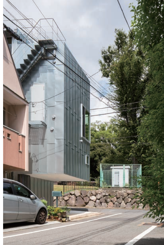
東側の道路より見る。
