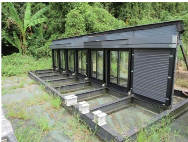
図10 実部材の暴露状況
