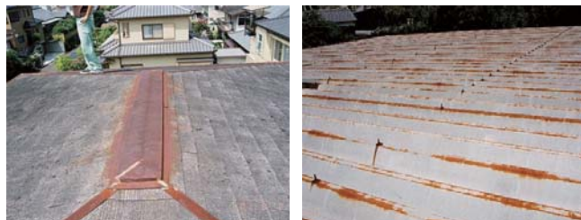
図6・7 築約30年の屋根鋼板調査例
