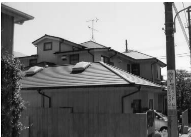
かぶせ工法によるファインスチール屋根
