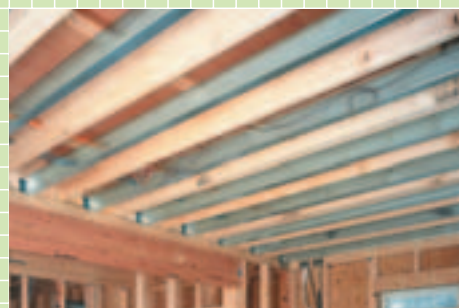
鋼製吊天井根太
