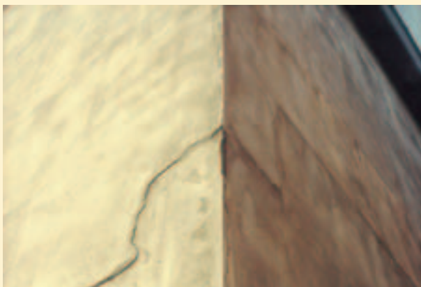
外壁の劣化事例
