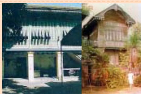
写真4 洋館(左:木造+煉瓦造、右:木造)
