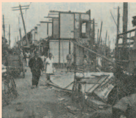
写真2 室戸台風による長屋の被害（出典：『建築雑誌』）
