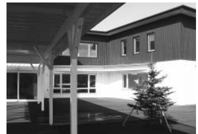
知的障害者施設ジャンプレッツ(2003年) ファインスチール角波の2階外壁
