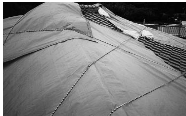
ビニールシートでの雨漏り防止
