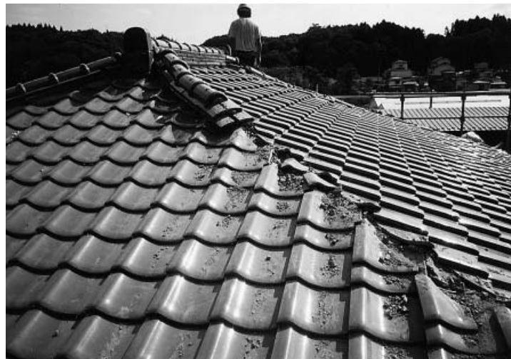
地震による瓦屋根の損傷
