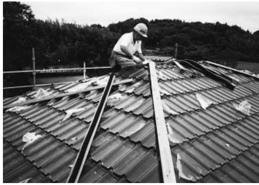
瓦を剥がして形状瓦を敷く
