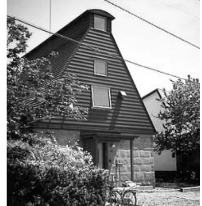
川沿の三角屋根(1990年) ファインスチール横葺の屋根と外壁
