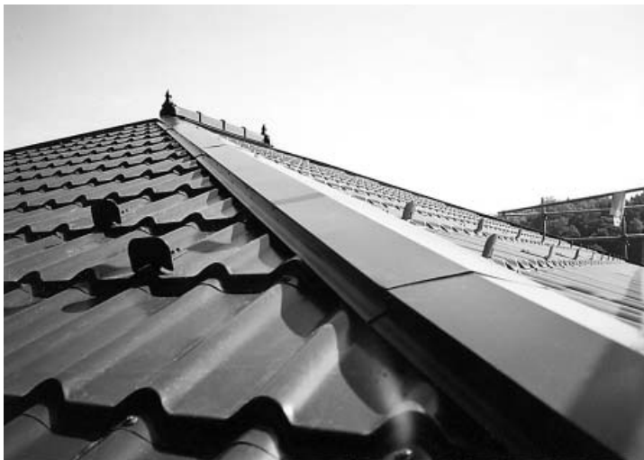
ファインスチールの形状瓦でリフォームされた屋根 (施工:(有)松田板金工業)
