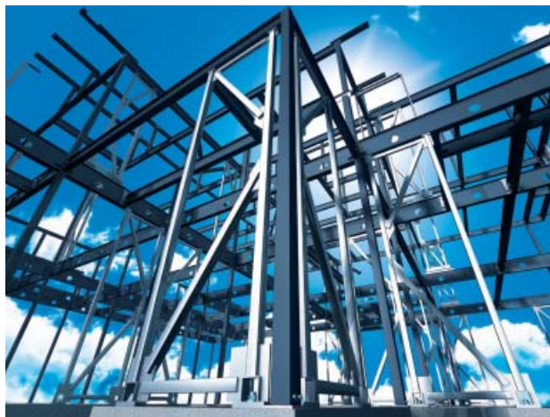
柱・梁ラーメン構造
