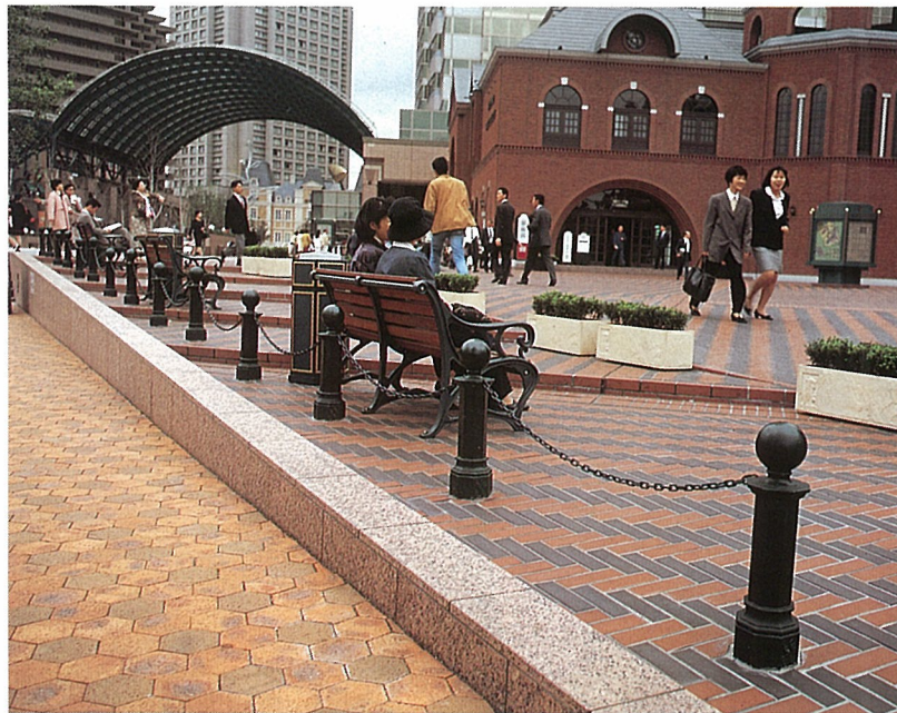
名 称／車止め 施工材料／鋳鉄
