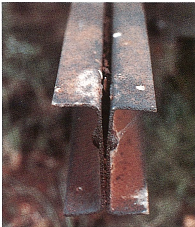
個材の向きは良いが、合せ部の勾配がないため水が溜まった例
