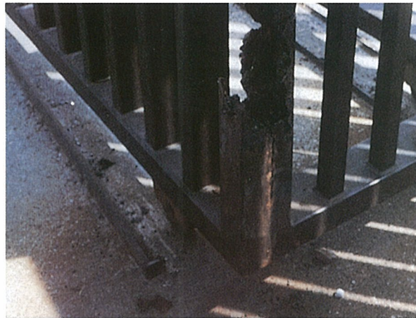
内部に水などが溜まり、内側より腐食が進行した例
