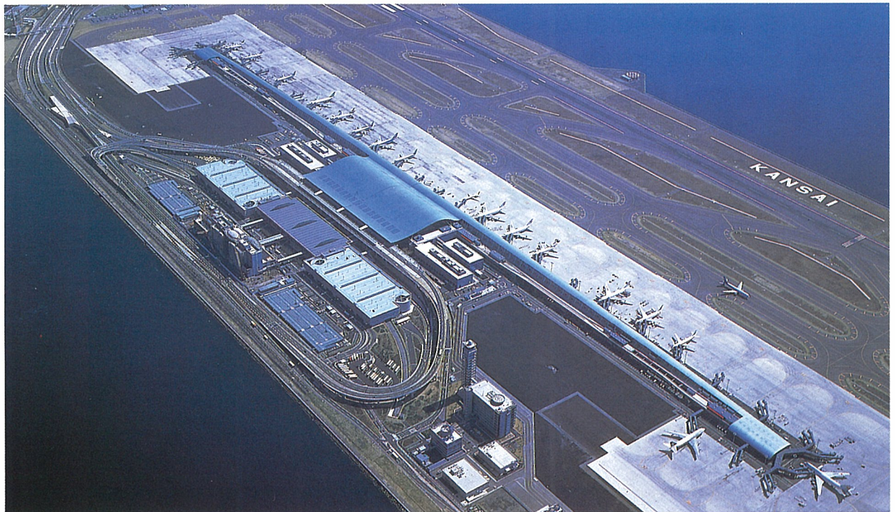
関西国際空港旅客ターミナルビル 金属屋根（高耐食性ステンレスSUS447J1）
