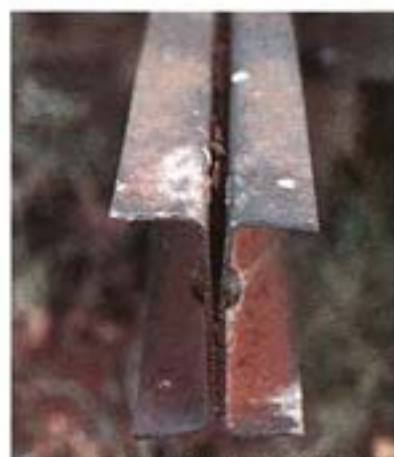
鋼材の向きは良いが、合せ部の勾配がないため水が溜まった例
