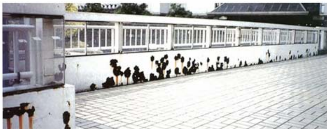
メンテナンスがされず、さびが発生しても放置されている例
