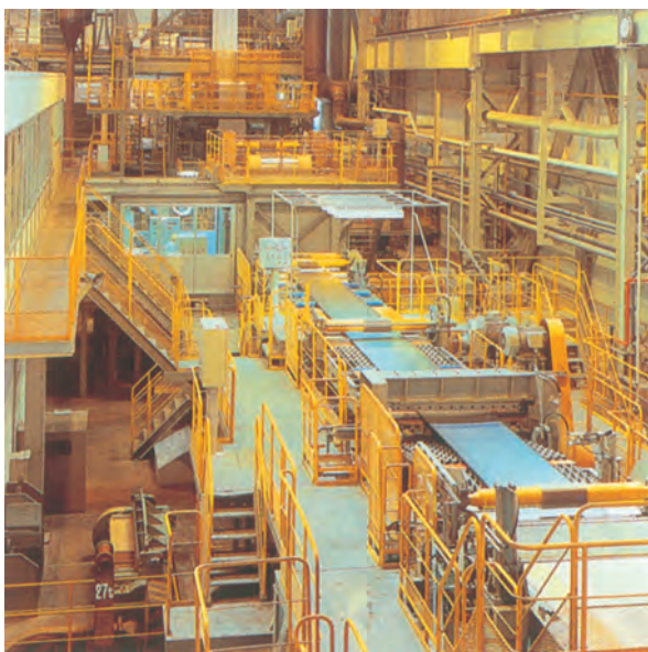
電気亜鉛めっき設備
