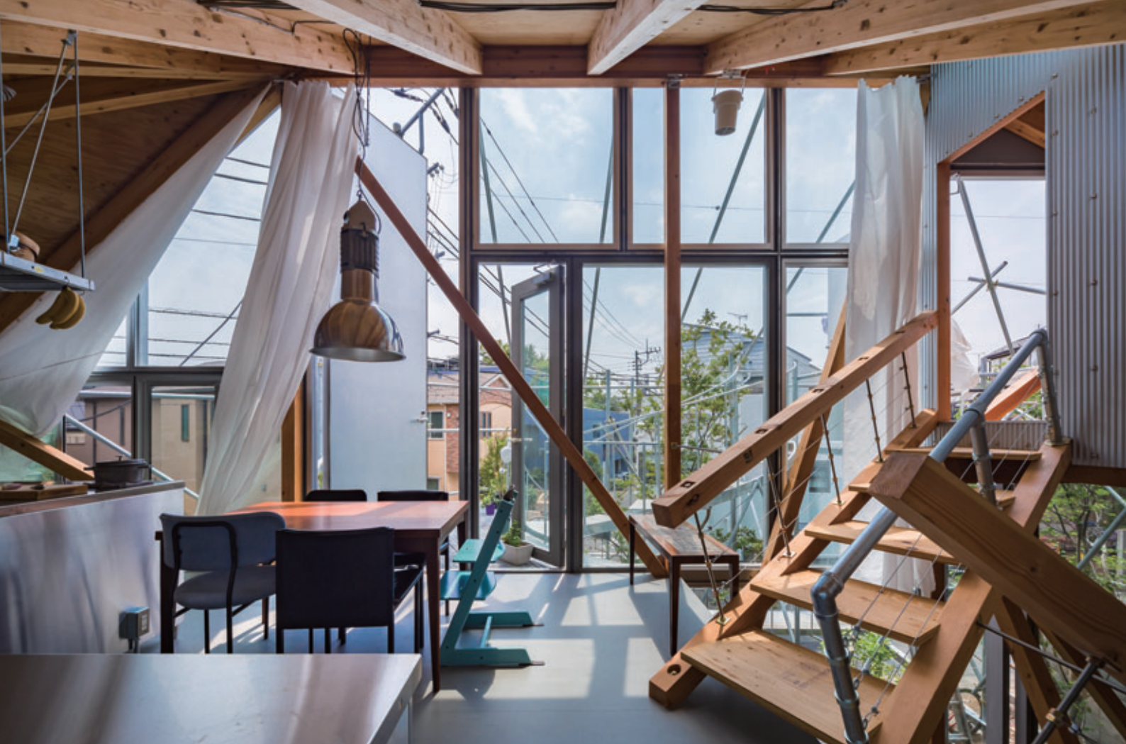
ダイニングからダイニングテラスを見る。内装材としてもガルバリウム鋼板が用いられている。
