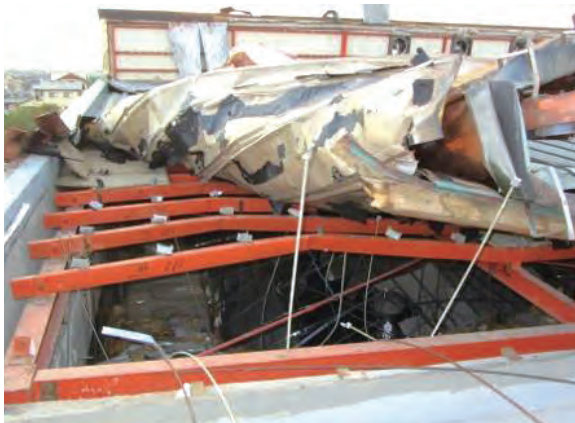
写真6 鋼板製の屋根ふき材及び母屋の破壊
