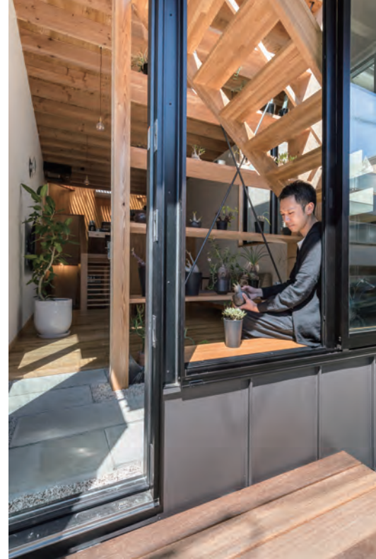
玄関土間の窓下枠はベンチになっている。
