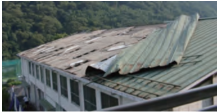
写真5.2.4a けらば付近から被害が発生し、 屋根ふき材が面状に剥がれた事例
