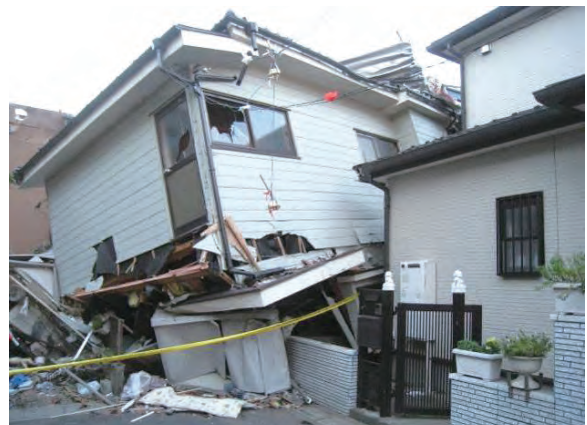
写真9 木造住家の倒壊事例
