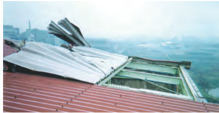
写真5.4.4 軒先に大きな風圧力が掛かり、 タイトフレームが脱落した事例
