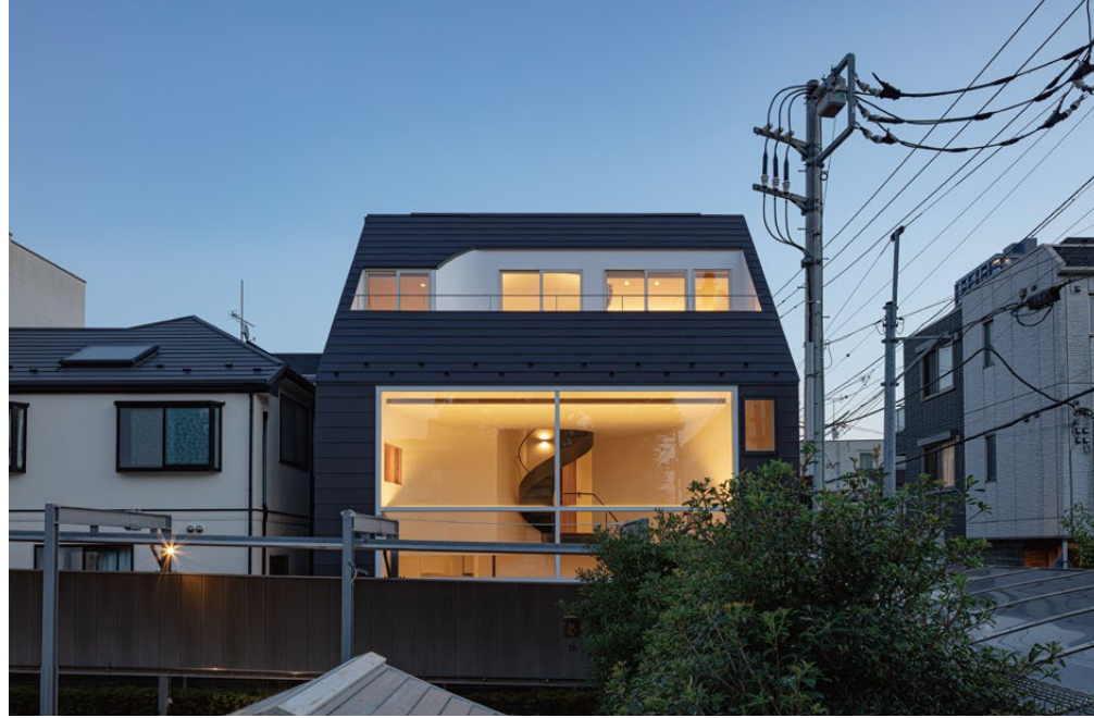
北側外観。この家もたらす様々な体験が、おおらかさとのびやかさと、何らかの刺激とともにある。そのような住宅をめざした。
